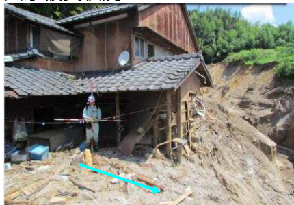
人家被災状況
