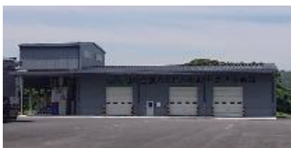
粃殻再資源化施設全景
