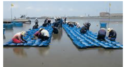
砂利袋の設置作業
