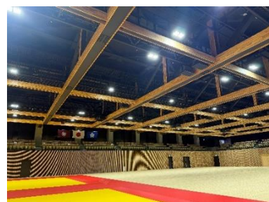
木質化された福岡武道館
