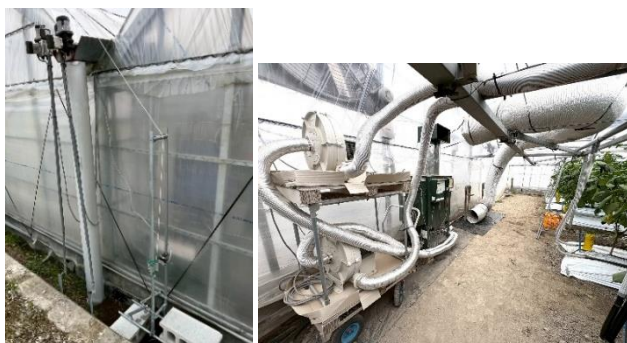
写真1 換気部の開閉と連動するCO 2 施用技術 および局所施用
