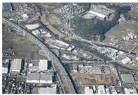
②多々良川浄化センター
