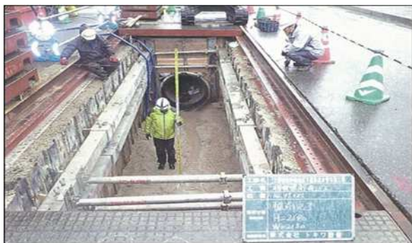
【送水用耐震管布設工事】
