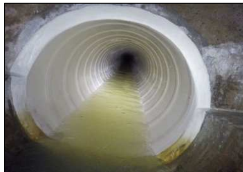
【下水道管路耐震化対策（管更生工法）】
