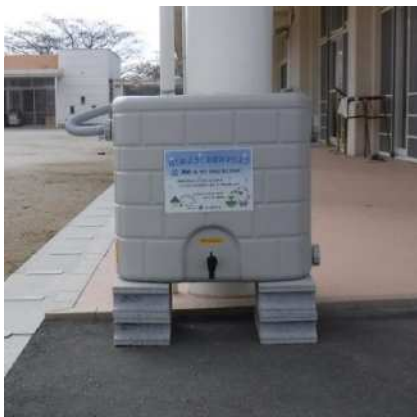
雨水タンクの設置状況
