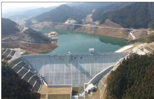
伊良原ダム(みやこ町)
