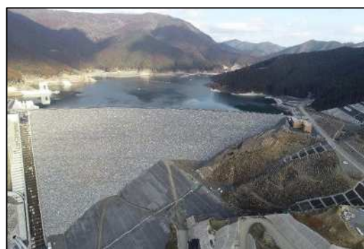
小石原川ダム(朝倉市)
