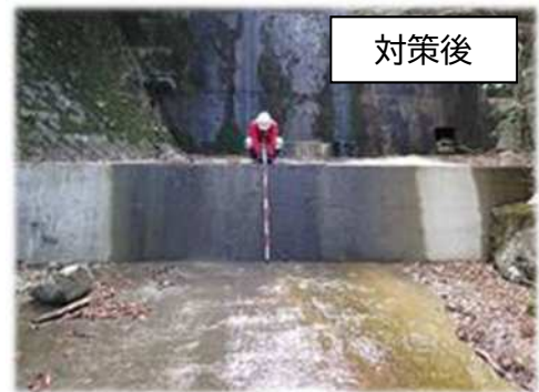
老朽化対策の例（洗堀箇所の修繕）
