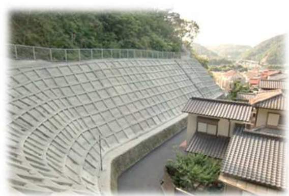
黒川地区(北九州市門司区)における急傾斜地崩壊対策事業(現場打のり枠)
