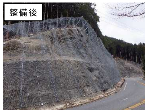
主要地方道 飯塚大野城線 法面崩壊対策 (糟屋郡須恵町)
