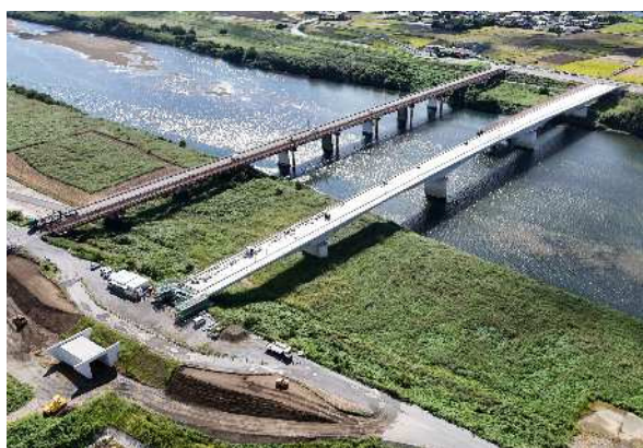
主要地方道 甘木田主丸線「両筑橋」 (久留米市田主丸町、朝倉市)
