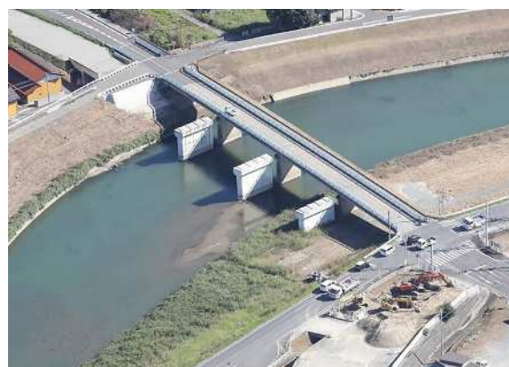
一般県道 直方鞍手線「新入大橋」 (直方市)
