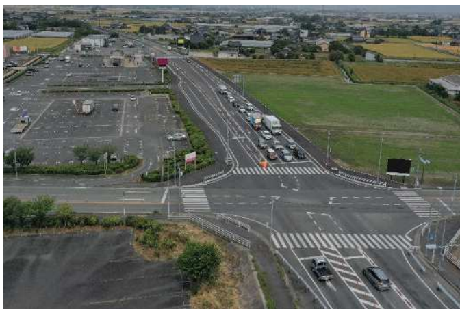
国道 442 号 大木大川バイパス 4 車線化 (大川市)
