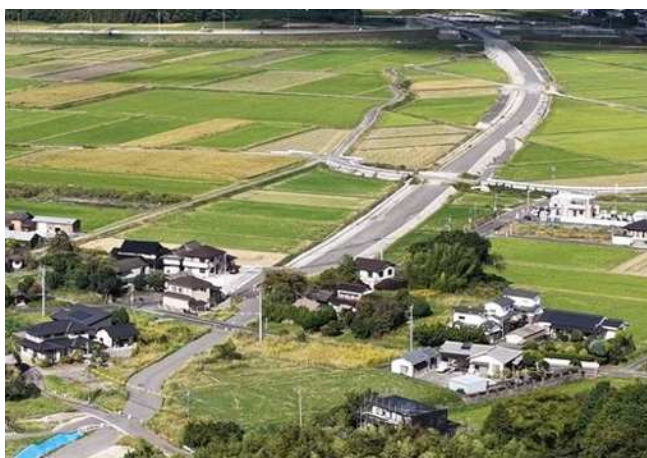
主要地方道 飯塚福岡線 金生工区 (宮若市)
