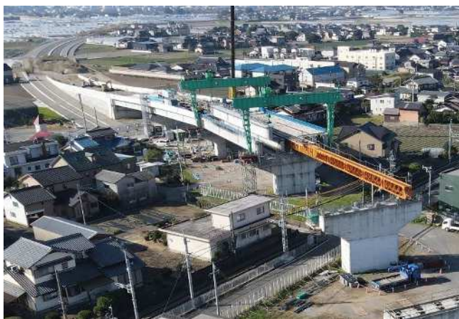
主要地方道 久留米筑紫野線 北野大刀洗工区 (久留米市～三井郡大刀洗町)
