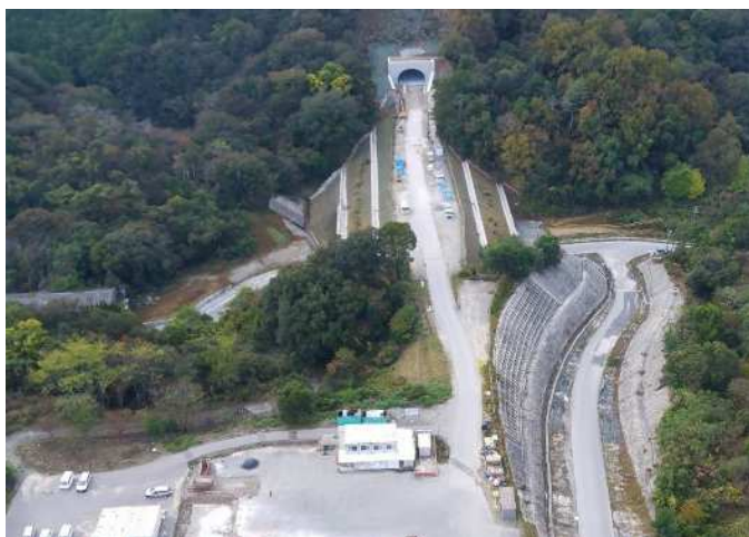
国道 322 号 嘉麻バイパス (嘉麻市)
