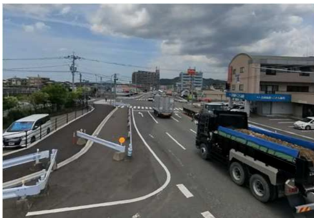
主要地方道 筑紫野古賀線 須恵工区 (粕屋郡須恵町)
