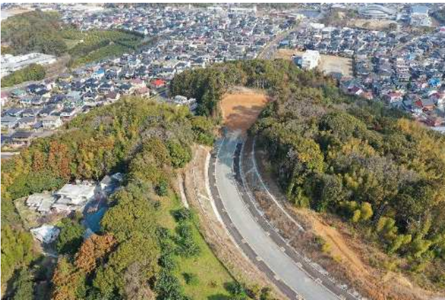
一般県道 原海老津線 高倉工区 (遠賀郡岡垣町)
