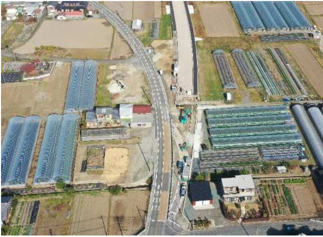
一般県道 柳川筑後線 水田工区 (筑後市)
