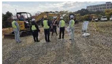
▲ICT 建設機械を用いた施工体験会
