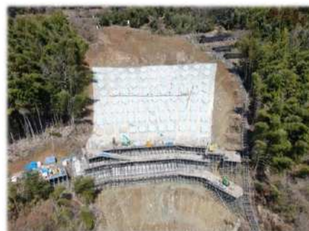
逆瀬谷地区地すべり対策施設事業状況（八女郡広川町）
