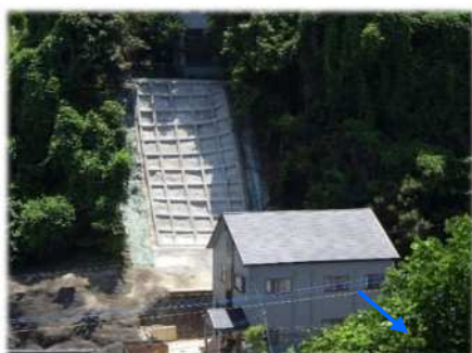
愛宕地区急傾斜地崩壊対策施設完成（福岡市西区）
