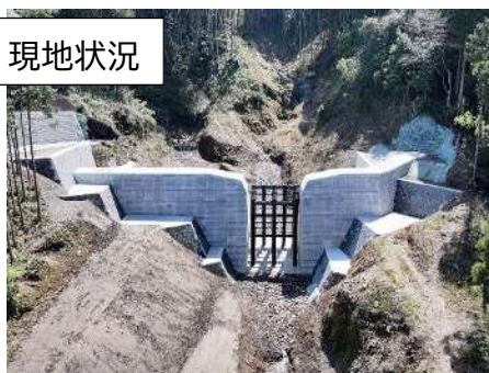
砂防堰堤本体 完成
