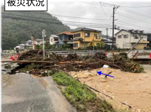
本木川 浸水被害の状況（福津市畦町・内殿）
