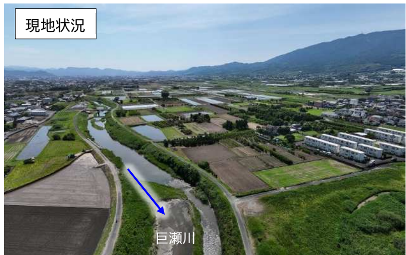
調節池予定箇所
