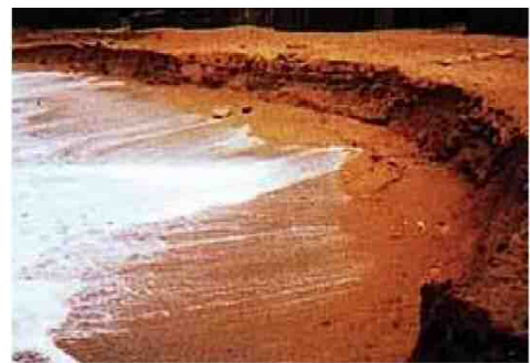
冬季波浪による浸食被害(新宮町)
