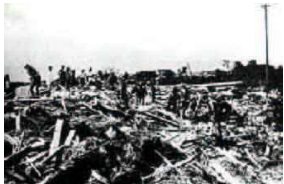
写真 1.4 高潮被害状況（熊本県熊本市沖新）
