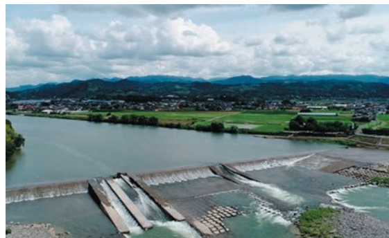
うきは市浮羽町古川 筑後川大石堰
