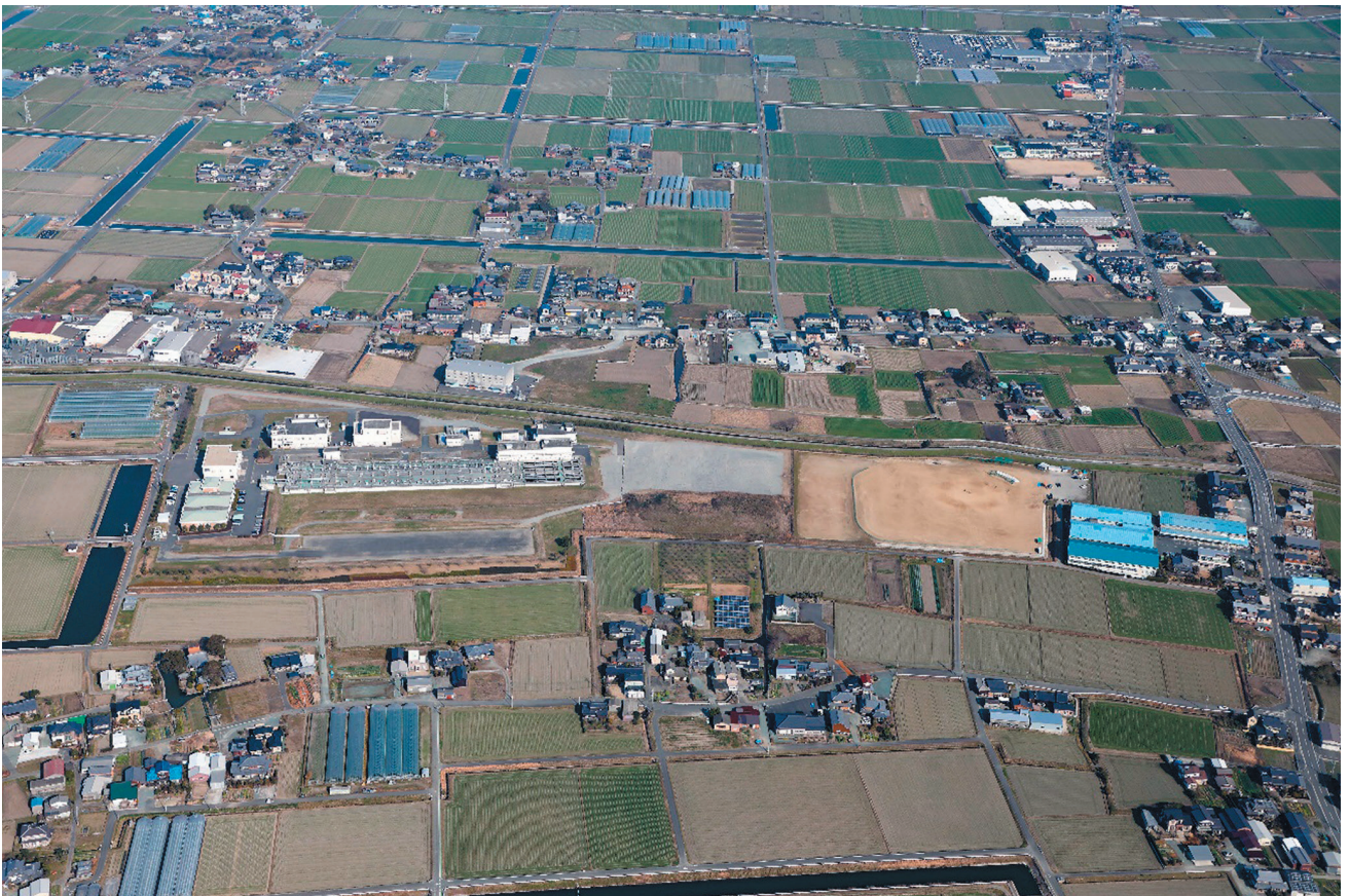
矢部川浄化センター
