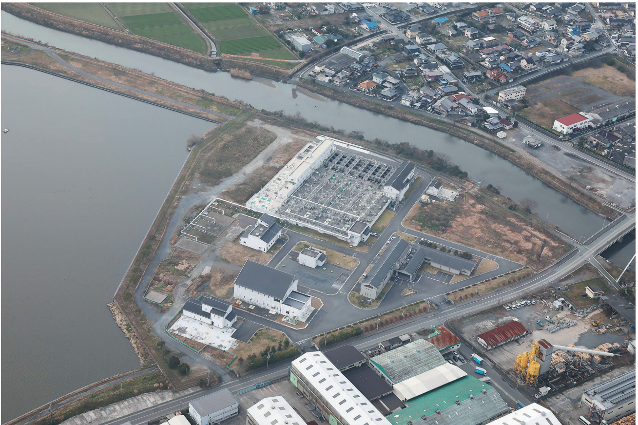
遠賀川下流浄化センター
