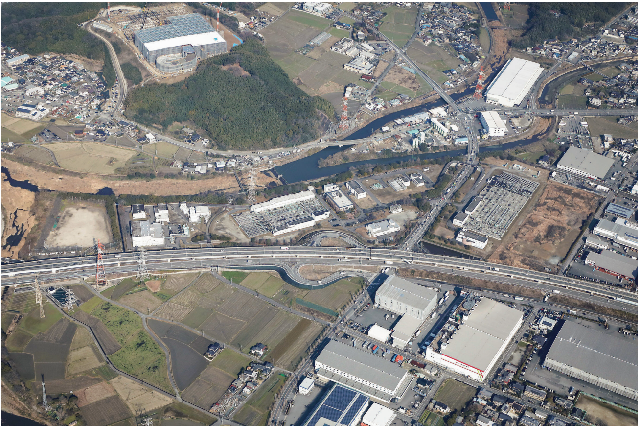
多々良川浄化センター
