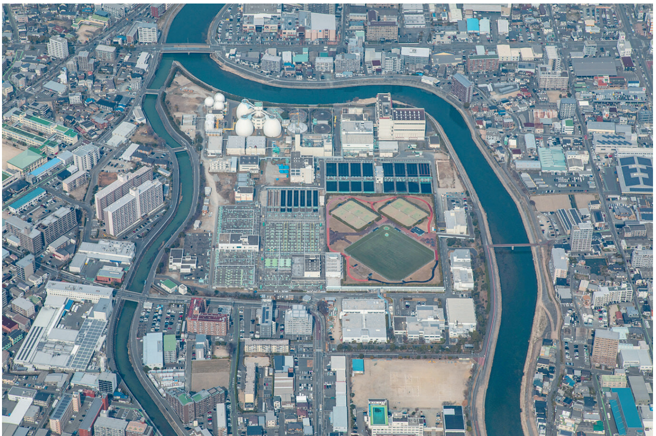
御笠川浄化センター
