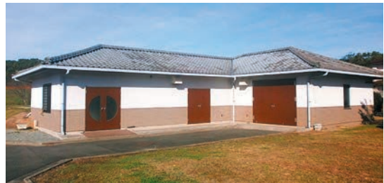
上長田浄化センター（みやま市）
