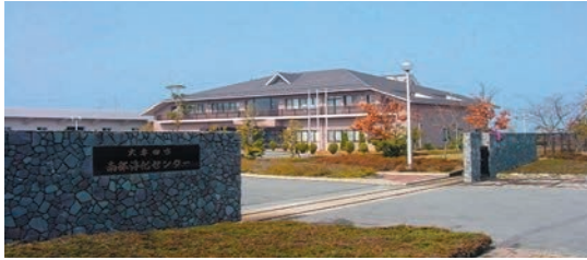
南部浄化センター（大牟田市）
