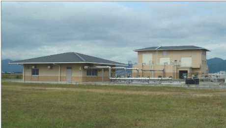
三輪中央浄化センター(筑前町)
