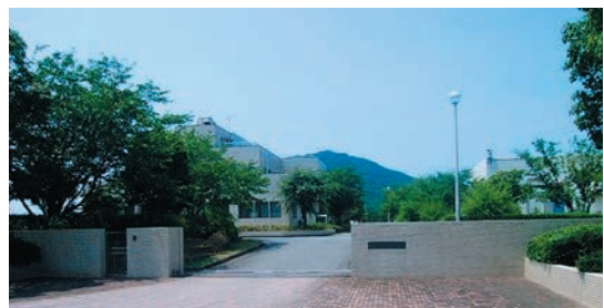
前原下水管理センター（糸島市）
