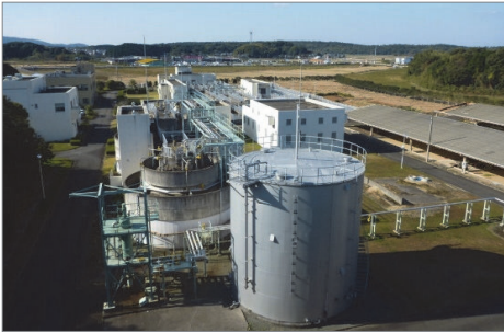
岡垣町浄化センター(岡垣町)
