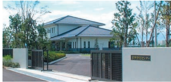
吉井浄化センター（うきは市）
