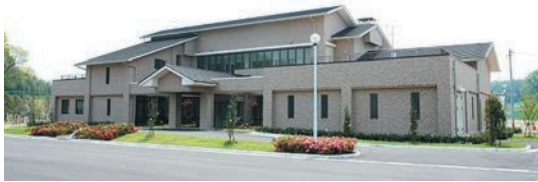
福間浄化センター（福津市）
