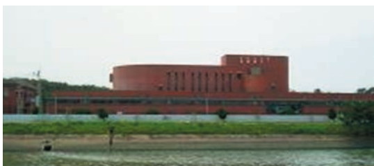
古賀水再生センター（古賀市）
