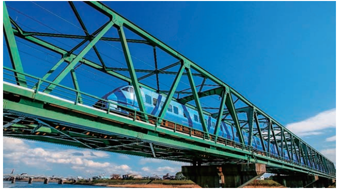
吉富町 山国川鉄橋
