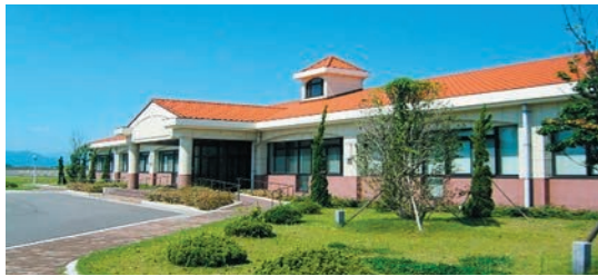
行橋浄化センター（行橋市）
