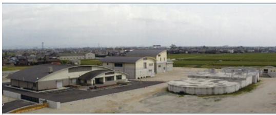
太川市水処理センター 管理棟（大川市）
