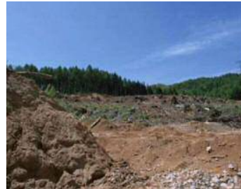
住宅地造成のための森林伐採
