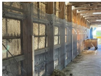
サシバエネット設置
