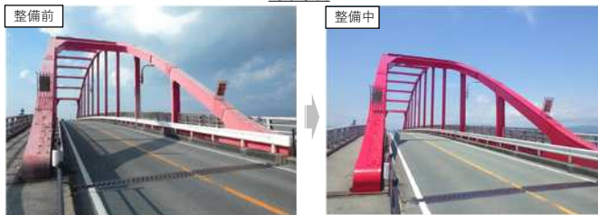
対策事例 【大牟田川副線「新田大橋」(大川市)】
