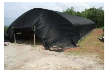
ハウス施設整備
