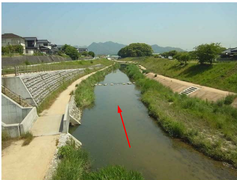
5k300 古川橋より下流方向の様子
