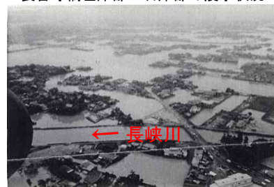
長峡川の被災写真③ 長音寺橋左岸部～右岸部の浸水状況
