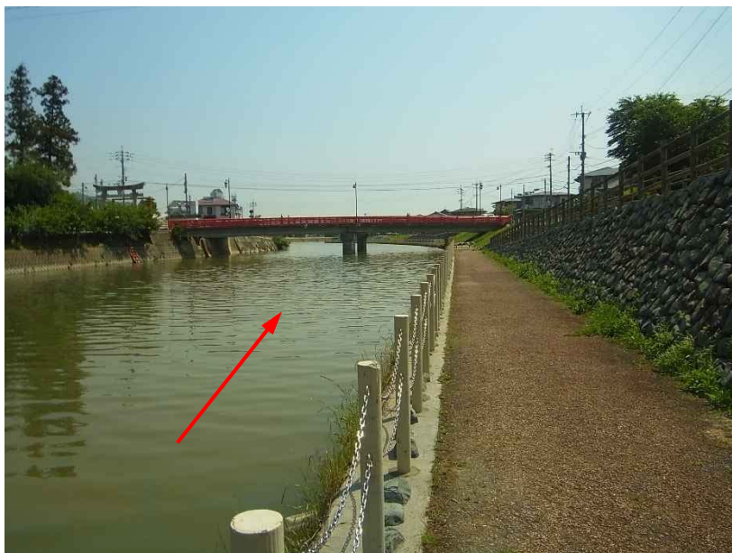
3k700 上流側より長音寺橋付近の様子
