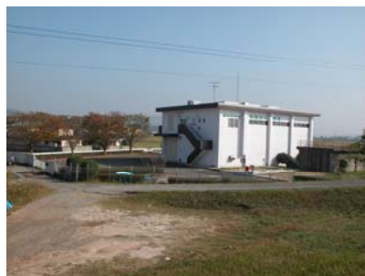
学頭排水機場(三緒浦川)
