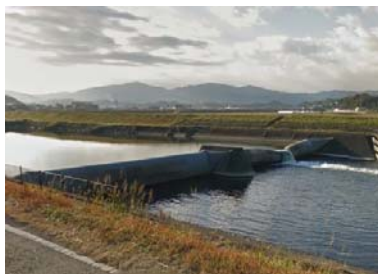
白門堰現況写真
