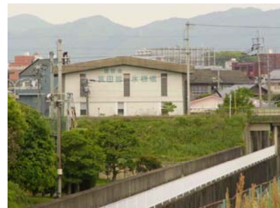
菰田排水機場(熊添川)
