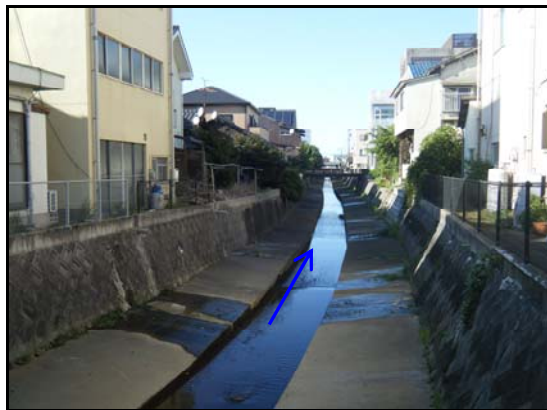
熊添川施行区間の現況写真
