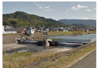
中川原堰現況写真
