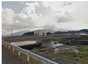
光代堰現況写真
