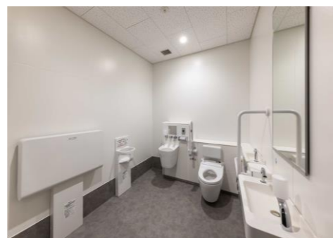
[福岡武道館 バリアフリートイレ]
