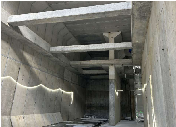
施工状況（地下調節池4工区）
