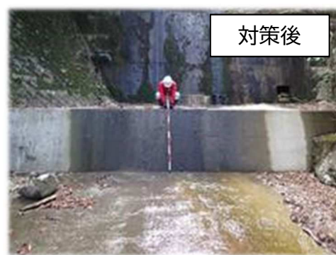
老朽化対策の例（洗堀箇所の修繕）
