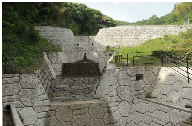
砂防堰堤(山中川 八女市黒木町)
