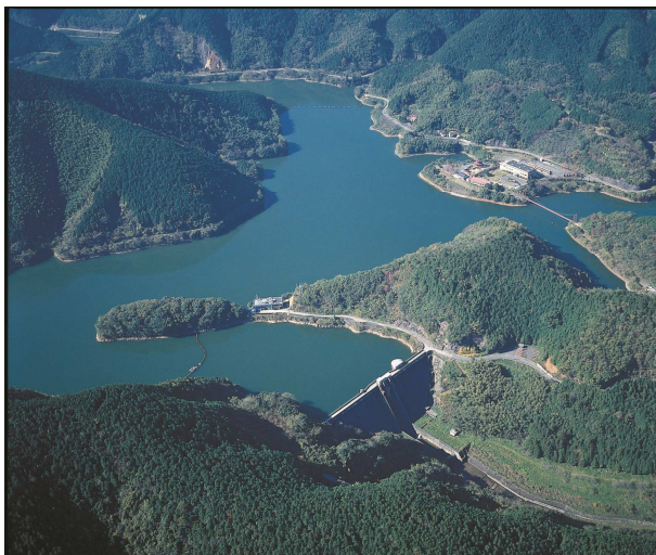
力丸ダム(八木山川 宮若市)
