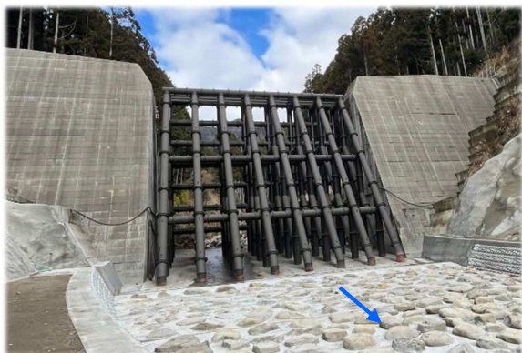
本迫川砂防堰堤完成(朝倉郡東峰村)
