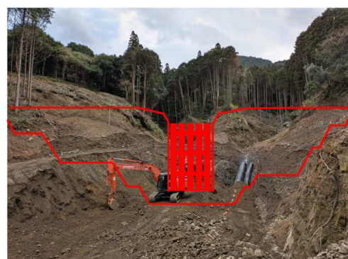
砂防堰堤本体 施工中
