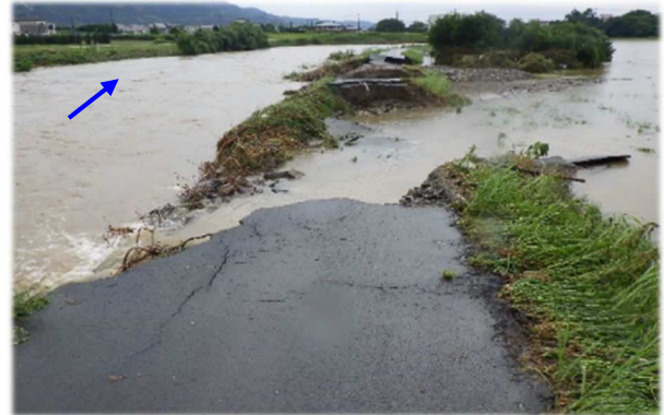
巨瀬川堤防決壊（久留米市田主丸町）
