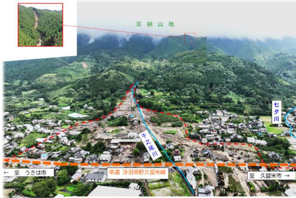
千之尾川土砂災害土砂災害（久留米市田主丸町）
