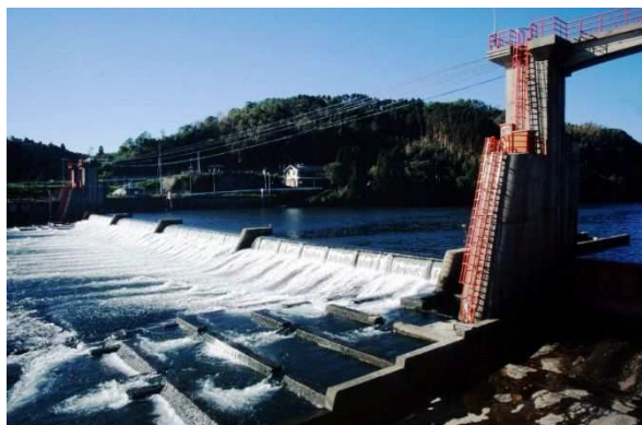
白石堰（大牟田工業用水道）
