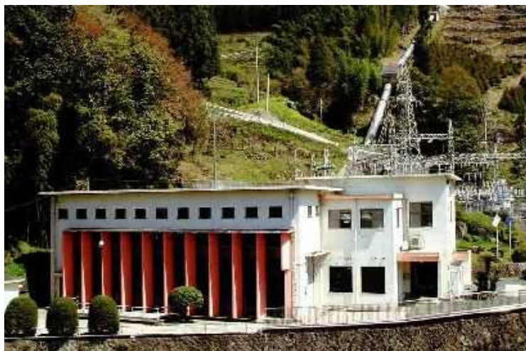
木屋発電所及び矢部川発電事務所
