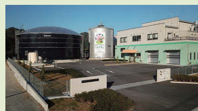
バイオマスセンター「ルフラン」 （みやま市）
