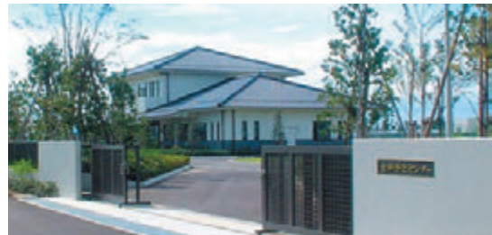
吉井浄化センター（うきは市）
