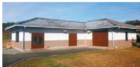
上長田浄化センター（みやま市）
