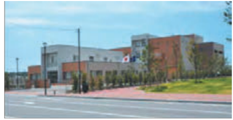
新宮中央浄化センター(新宮町)
