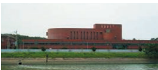
古賀水再生センター（古賀市）
