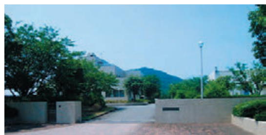
前原下水管理センター（糸島市）
