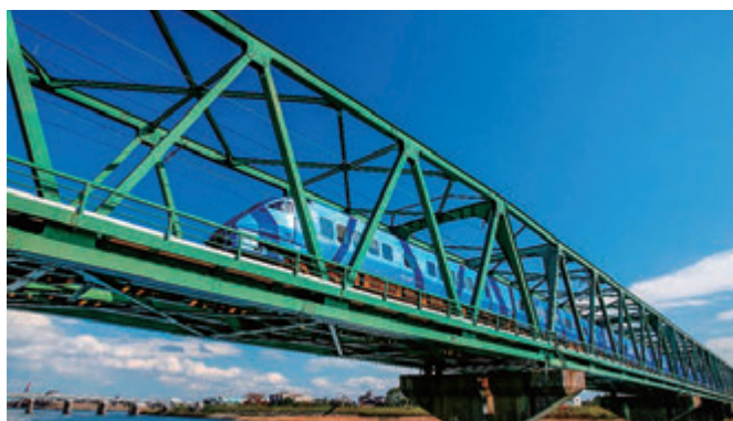
吉富町 山国川鉄橋
