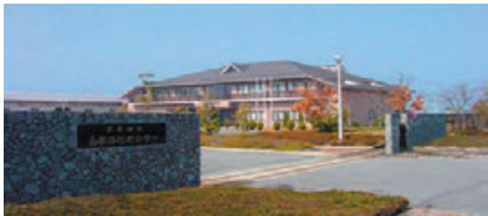
南部浄化センター（大牟田市）
