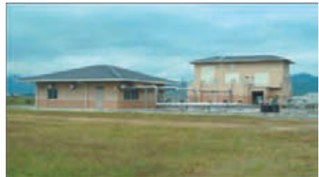
三輪中央浄化センター(筑前町)
