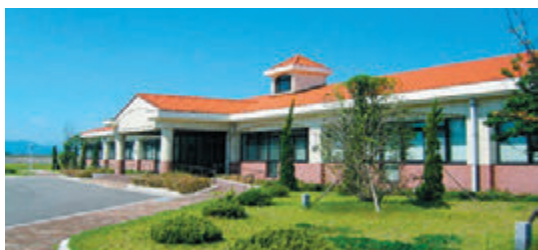
行橋浄化センター（行橋市）
