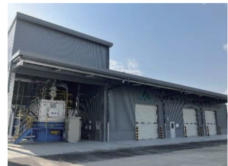
もみ殻再資源化施設の外観
