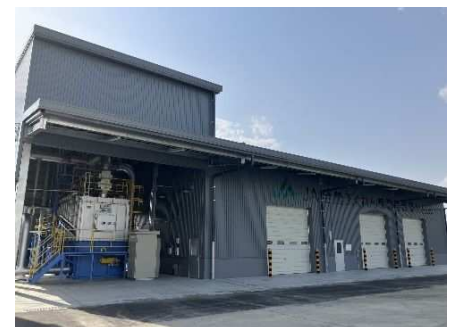
もみ殻再資源化施設の外観
