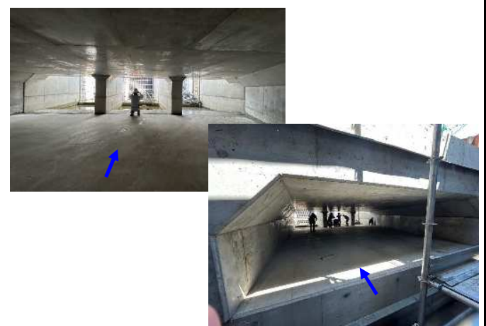
発進立坑から排水機場への水路
