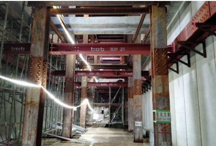
施工状況（地下調節池4工区）
