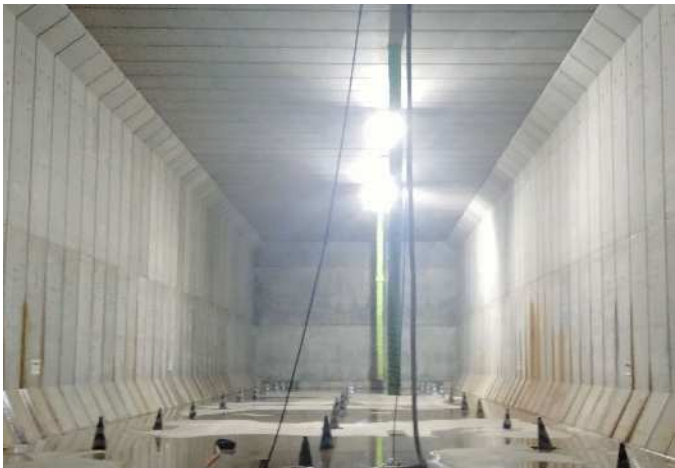
施工状況（地下調節池3工区）
