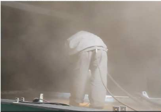
従来技術(オープンブラスト工法) 施工中
