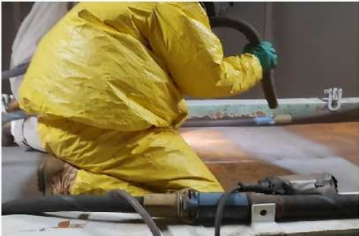
従来技術(オープンブラスト工法) 施工中
