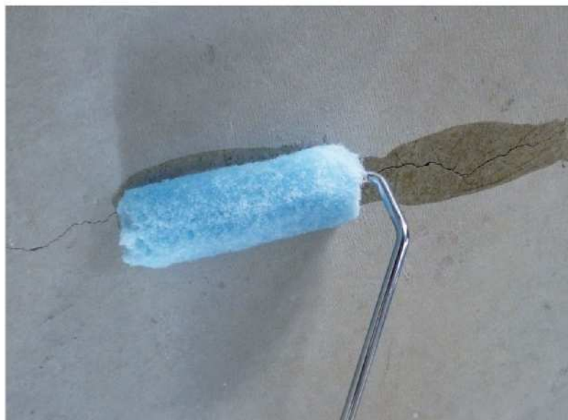
【CAP工法の施工状況】
