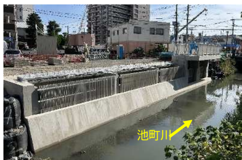
施工状況（分水工）
