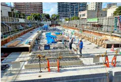
施工状況（地下調節池3工区）
