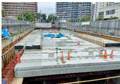
施工状況（地下調節池3工区）
