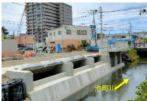
施工状況（分土工）
