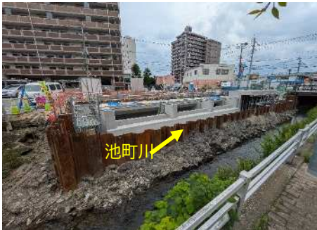
施工状況（分水区2工区）
