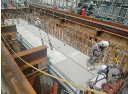
施工状況（地下調節池3工区）
