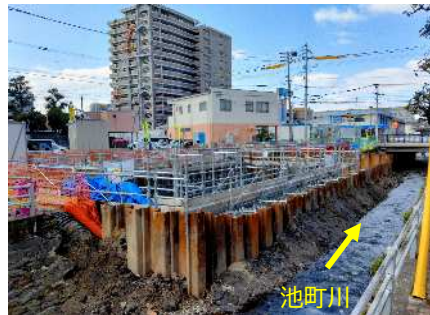
分土工の施工状況（分土工築造工事）
