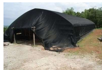
ハウス施設整備
