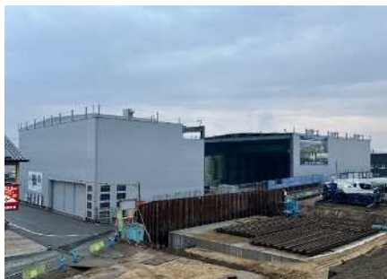
防音ハウス解体状況
