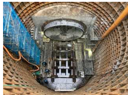
到達立坑内状況 (シールド機解体完了)
