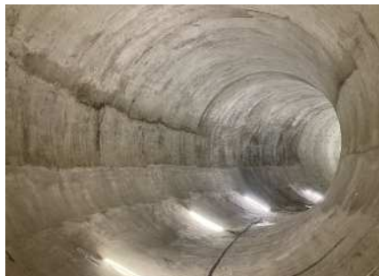
坑内状況 (発進側 急曲線部被覆工完了)
