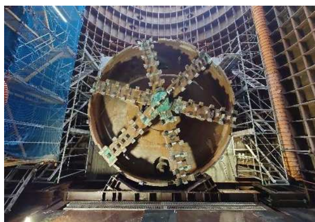
到達立坑内状況 (シールド機所定位置到達)
