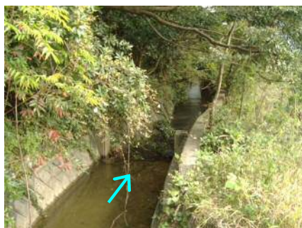
写真 1.1 相割川上流部 (2k900 付近)
