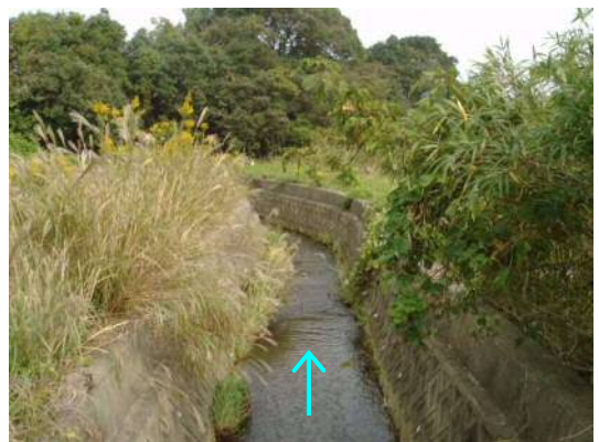
写真 1.8 相割川上流部（2k950 付近）
