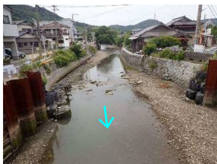
写真 1.3 相割川下流部 (1k000 付近)
