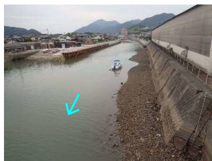
写真 1.4 相割川下流部 (0k400 付近)
