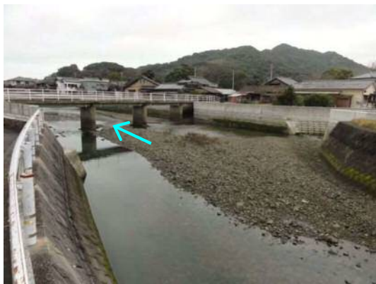
写真 1.5 相割川下流部（0k800 付近）
