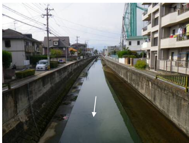
写真- 1.2 七隈川〔0k070、一の橋より上流〕
