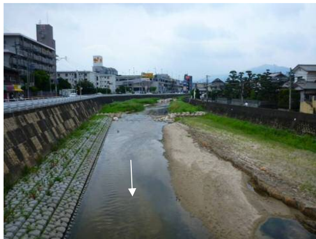
写真- 1.1 樋井川〔3k870、田島橋より上流〕
