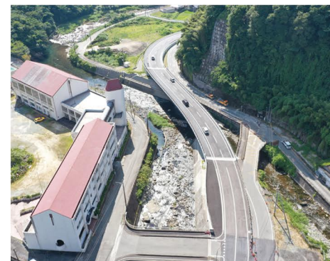
一般国道 442号 宮ノ尾橋（八女市）
