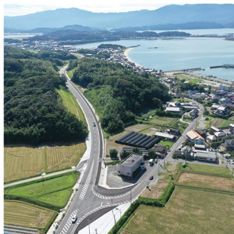
③主要地方道 福岡志摩前原線 (糸島市)
