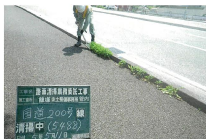
歩道端部の清掃
