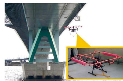
橋梁定期点検の状況
