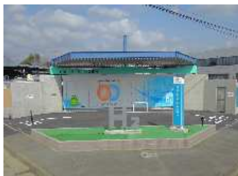
水素ステーション
